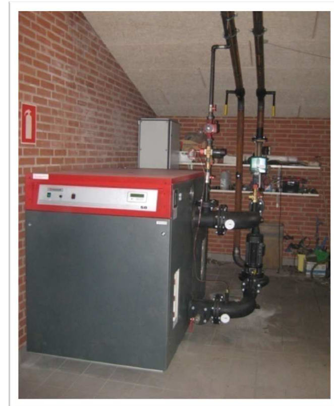
400 Volt – 0,3 til 3 MW
